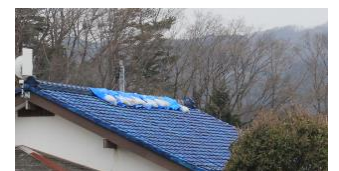
一部損壊（屋根瓦の被害）が目立つ山元町住家被害（3月下旬）
