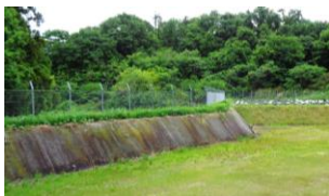
除染土の仮置場状況 (丸森町上滝地区)
