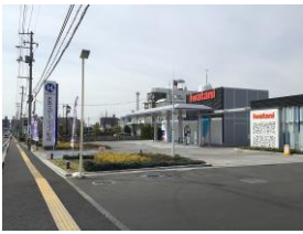
仙台市幸町 水素ステーション
